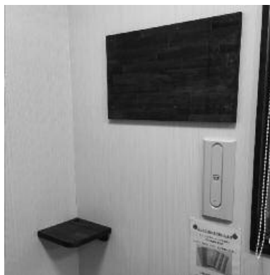
壁補強および棚設置
