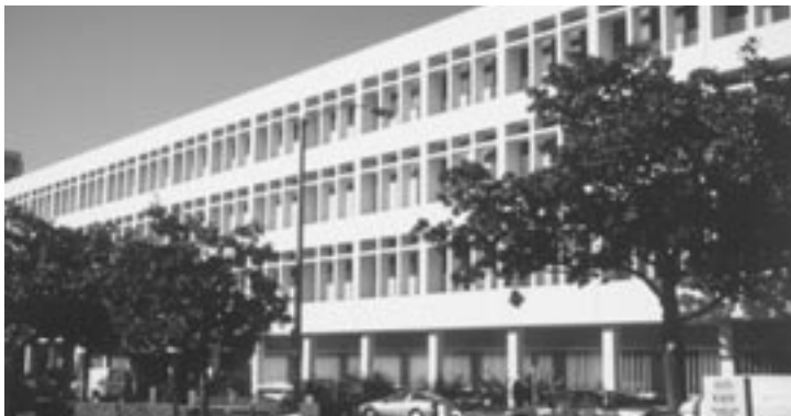
地下1階、地上4階のUSC歯学部の建物
